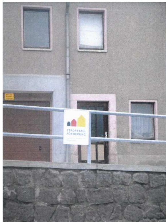
Stützmauer an der Peniger Straße nach der Instandsetzung (2014)
