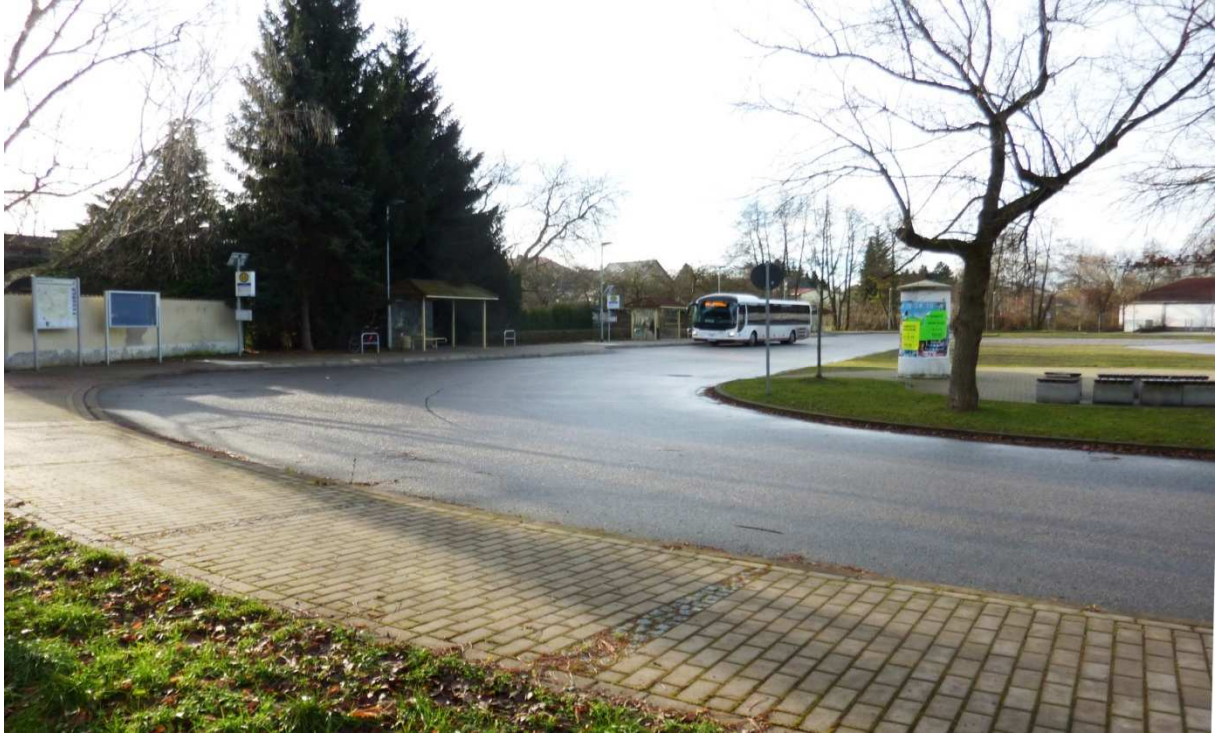
Zentralhaltestelle nach der Sanierung (2014)
