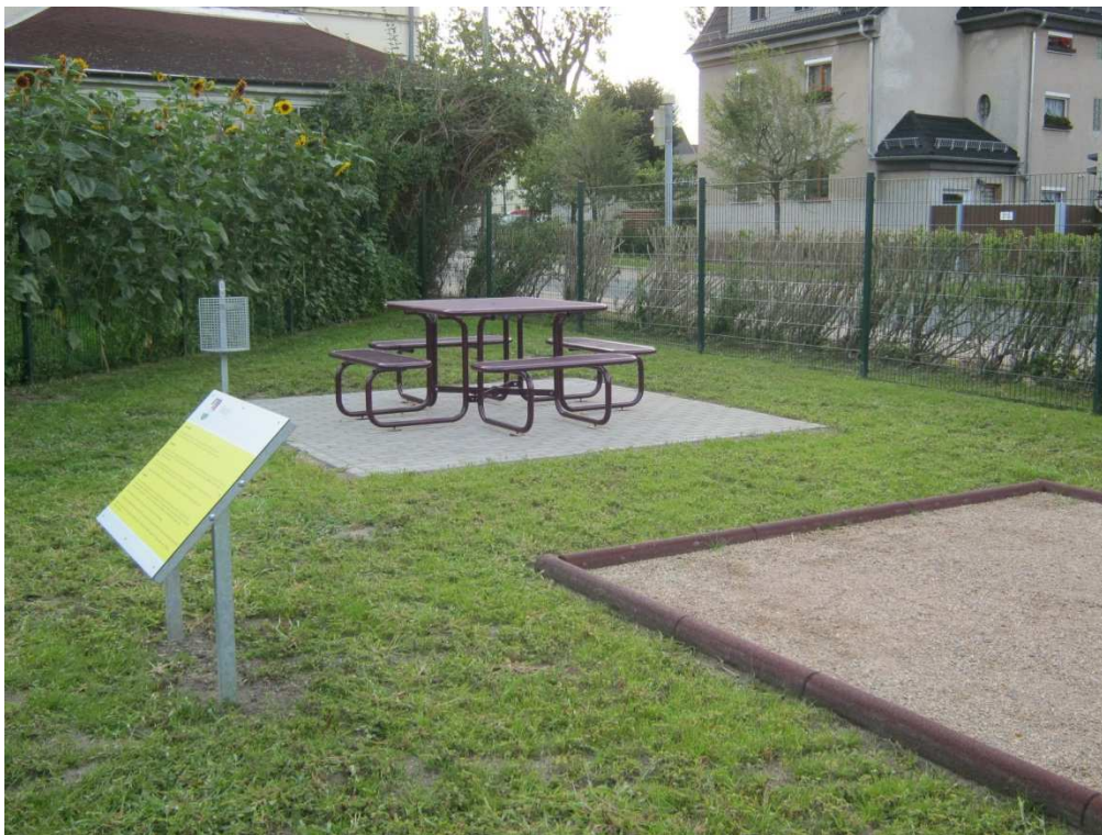
Mehrgenerationenspielplatz nach Umbau und Fertigstellung (2014)
