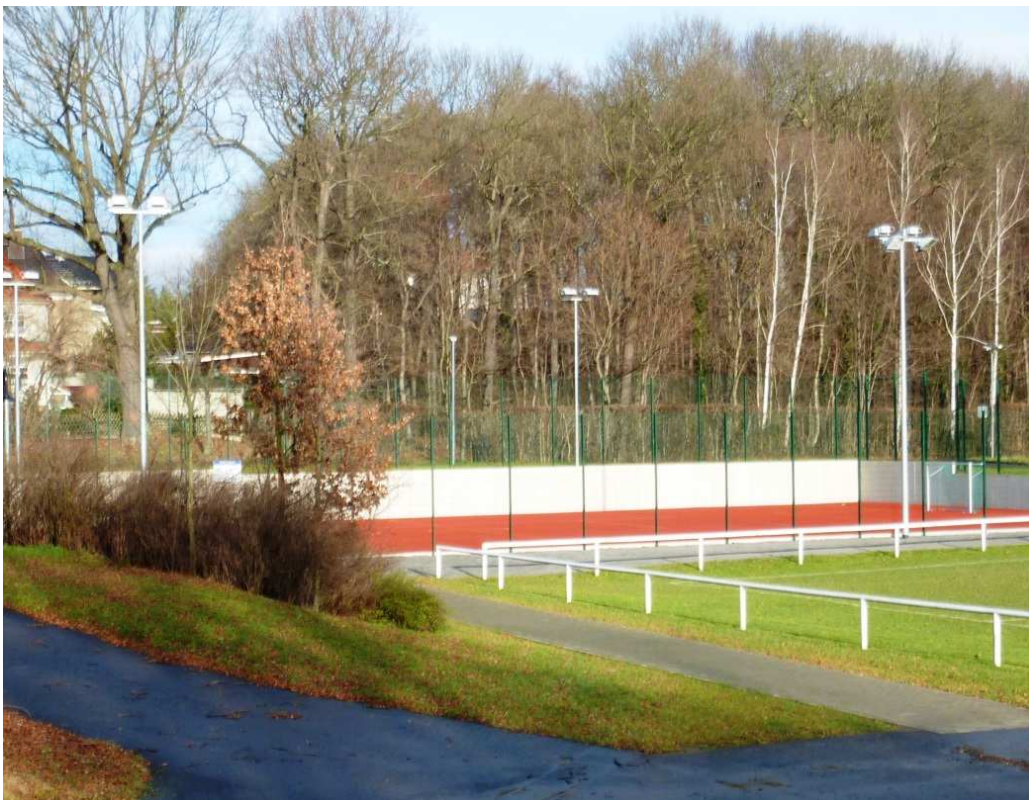
Spiel-, Sport- und Freizeitfläche „Am alten Sportplatz“ nach der Sanierung (2014)
