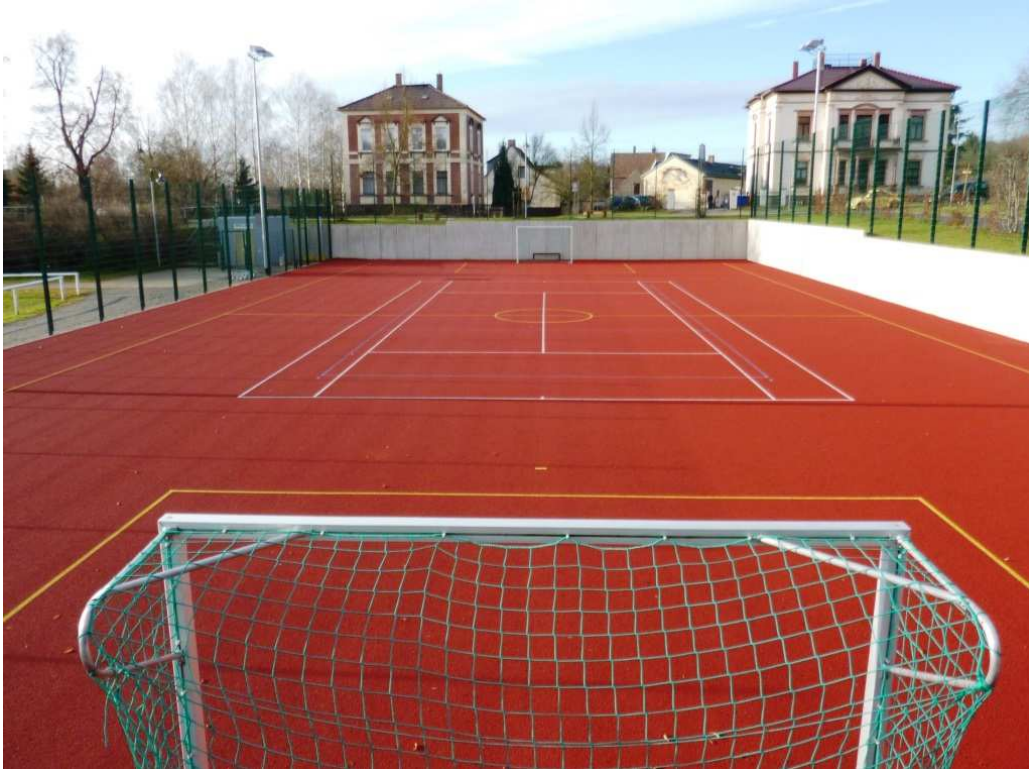
Spiel-, Sport- und Freizeitfläche „Am alten Sportplatz“ nach der Sanierung (2014)
