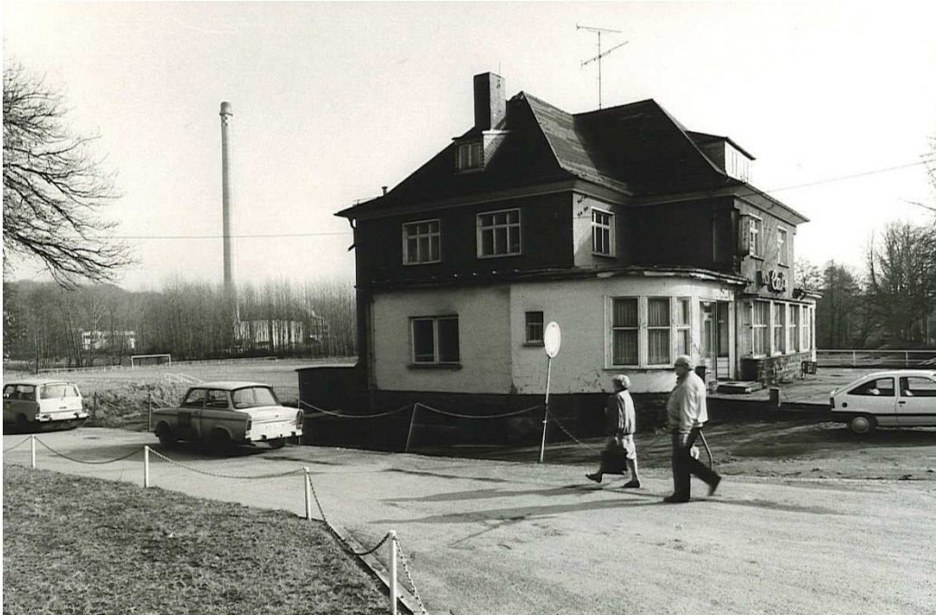
Bebauung Bahnhofstraße 23 (eh. Cafe "Otto" vor Rückbau und Nachgestaltung, 1992)
