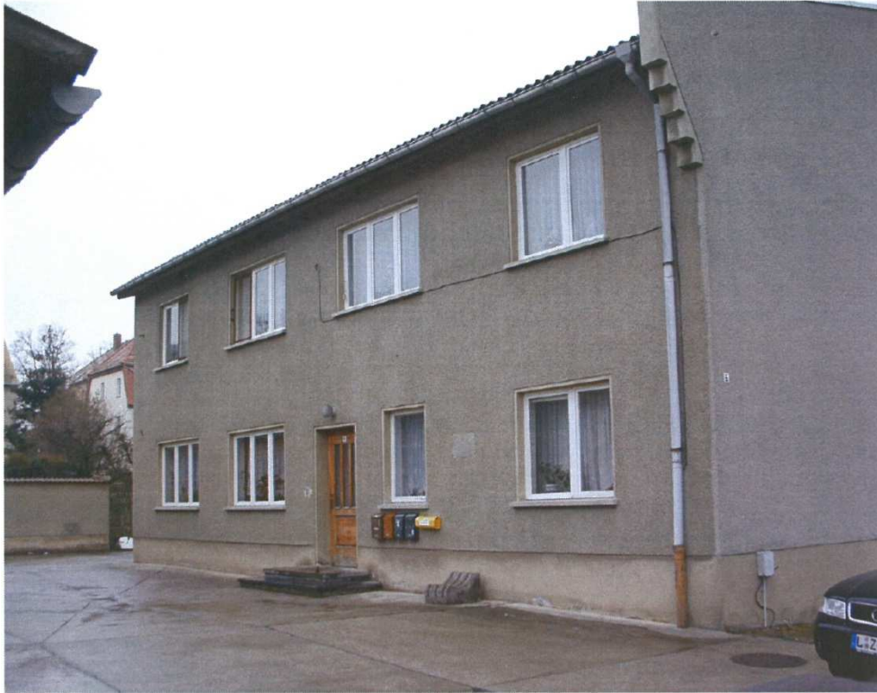
Von-Falkensteinstraße 3a vor der Sanierung (2005)
