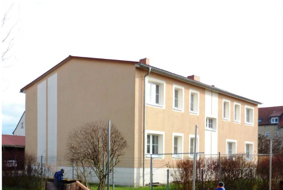
Von-Falkensteinstraße 3a nach der Sanierung (2005)
