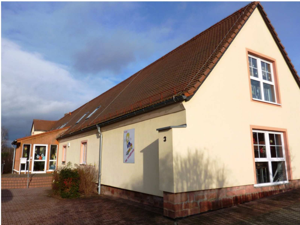
Hort nach Umbau und Sanierung (2014)
