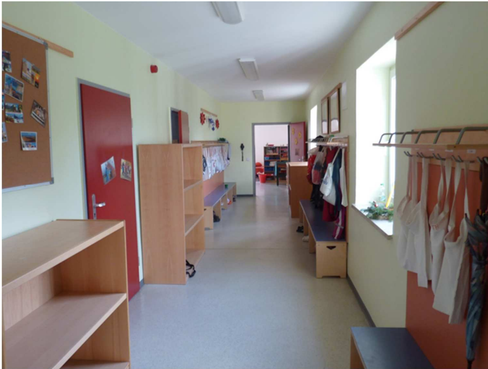
Flur im Erdgeschoss des Hortes nach Umbau und Sanierung (2014)
