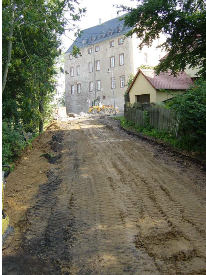
Während der Bauphase 2006, Blick Richtung Schloss
