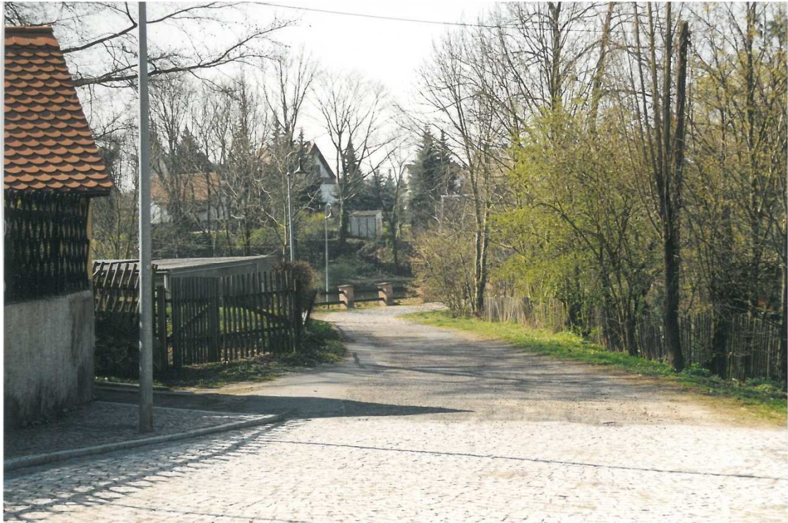
Mauerteichdamm vor der Sanierung (2002) mit Mittelpflaster
