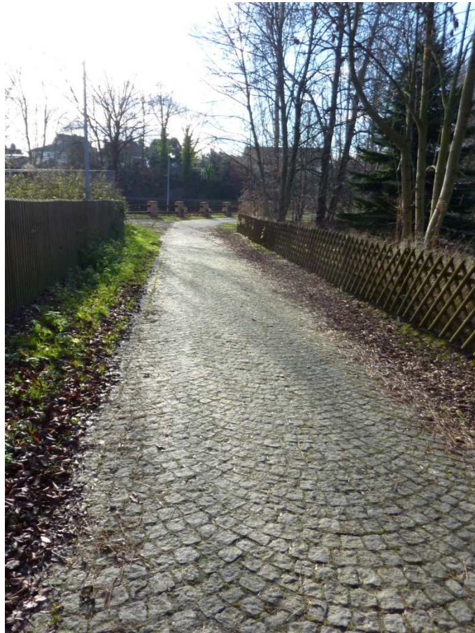
Mauerteichdamm nach der Sanierung (2014) mit Kleinpflaster
