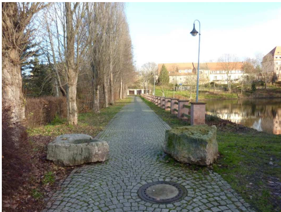
Mauerteichdamm nach der Sanierung mit Kleinpflaster (2014)
