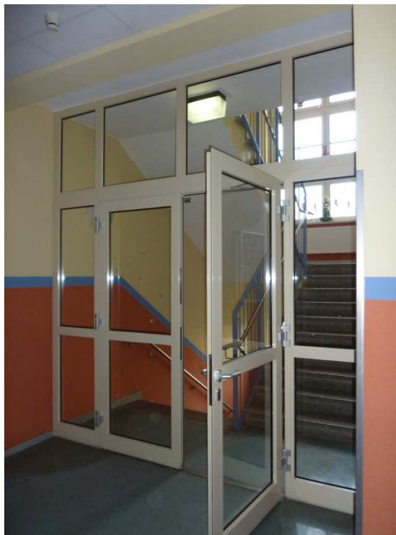
Feuerschutztür nach brandschutztechnischer Sanierung (2014)
