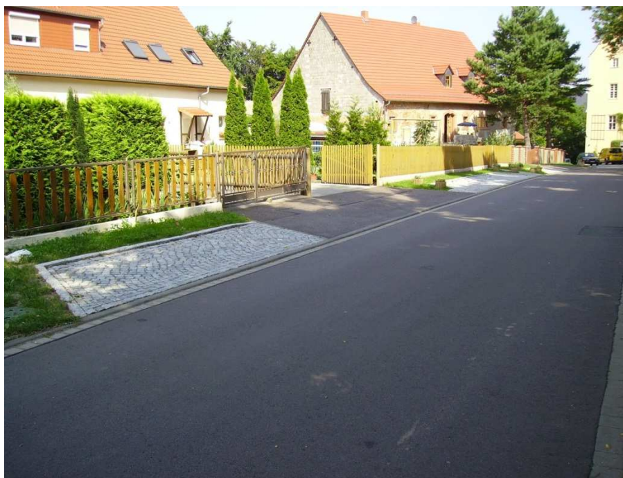
Nebenanlagen nach der Um- und Neugestaltung (2014)
